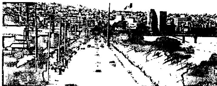
Vía Rápida, pavimentada con concreto hidráulico del programa PIRE 2008.
